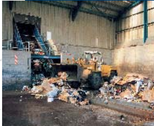
Aufgabeband in einer Hausmüllaufbereitungsanlage (England)
