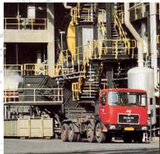
Naßetascher (100t/T) einer Industriemüllverbrennungsanlage (Niederlande)
